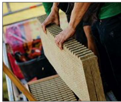
Der Kontur BR Brandriegel von ISOVER besteht aus einer schmalen Steinwolle-Platte mit einem speziellen Zahnprofil an der Vorderkante.
