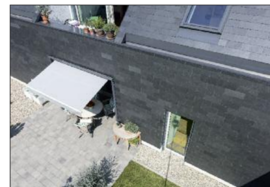
Eine Besonderheit des Daches ist die innen liegende Entwässerung im Bereich der Traufe, um so den reduzierten Eindruck des Hauses nicht zu stören.
