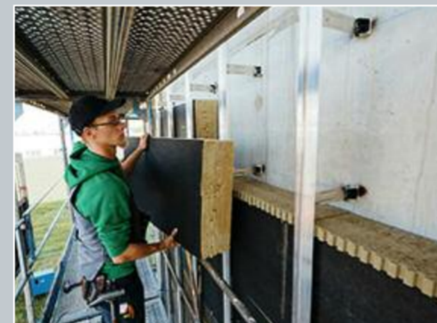
Die 300 mm starken Brandriegel wurden auf 240 mm Dämmstärke reduziert. Die Hinterlüftungsebene der Fassade von 40 mm wird vollständig ausgefüllt.
