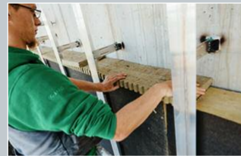
Die 300 mm starken Brandriegel wurden auf 240 mm Dämmstärke reduziert. Die Hinterlüftungsebene der Fassade von 40 mm wird vollständig ausgefüllt.
